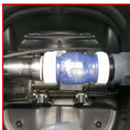
Zpětný ventil a čerpadlo odpadní vody
